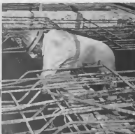
ariba henter largura di e waf a worde reemplazá y na unda tabata posde di marra bapor, secionnan nobo pa wanta bosta a worde instalá y concreto a worde bishá.
